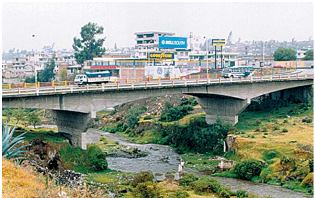
Puente sobre el Río Cutuchi, en Latacunga, que sería destruido por un lahar.
